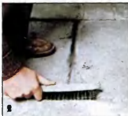
2 Для надежного сцепления между бетоном и самовыравнивающимся раствором, следует тщательно зачистить основу.
