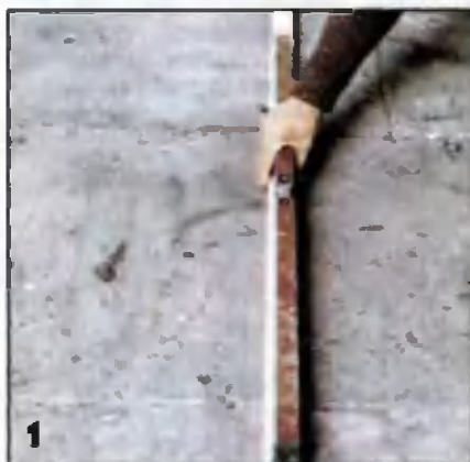
1 Чтобы определить требуемое количество самовыравнивающегося раствора, необходимо сначала с помощью уровня проверить уклон пола.
