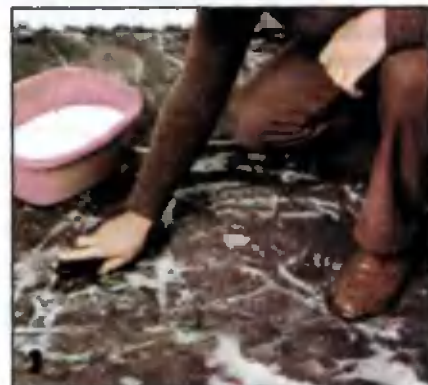
Необходимо удалить также следы масла и жира, например, с помощью мыльного раствора и щетки.
