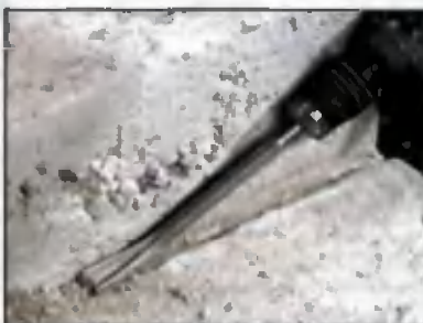
Канавку под электропроводку выбирают желобчатым долотом (Ø22x250 мм). Хвостовик SDS-plus облегчает смену инструмента в патроне перфоратора.
