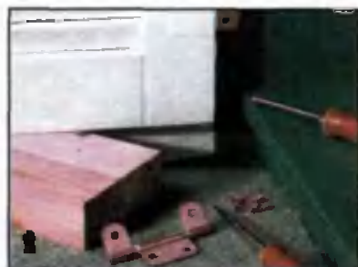
2 Вспомогательный брусок, подкладываемый под дверки при их навешивании, позволяет точно выверить их по высоте.
