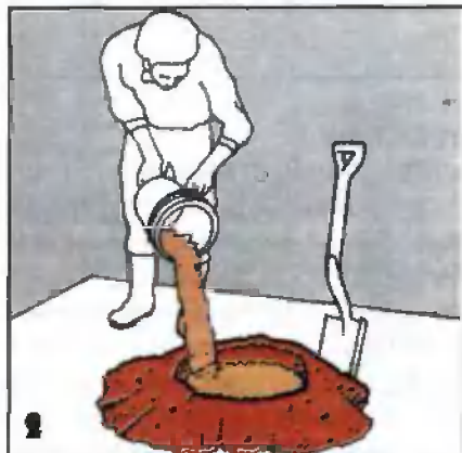
Добавив в смесь воду, эти компоненты перемешивают. Сформировав кратер, в него еще добавляют воду.
