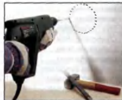
Простой способ сделать сквозное отверстие в обшивке. Для этого сверлят отверстия небольшого диаметра рядом друг с другом по окружности, а затем молотком с долотом выбивают круг.
