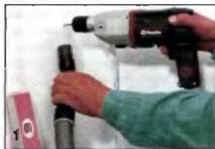
1 Несущие шины крепят к стене на дюбелях и шурупах. Пыль, образующуюся при сверлении отверстий под дюбели, собирают пылесосом.
