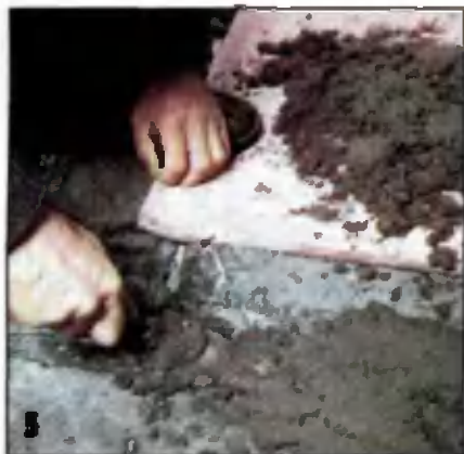
Не дав подсохнуть грунтовке, швы заполняют цементным раствором. Излишки последнего удаляют кельмой.
