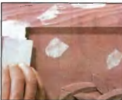
Деревянные рамы особенно уязвимы в местах соединения обвязок «на ус». Эти стыки надо хорошо склеить, а затем покрыть тонкой шпатлевкой для дерева.
