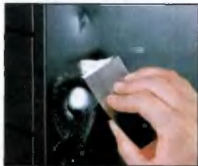
Металлические поверхности требуют особой подготовки. Соответствующая шпатлевка не должна давать усадку при высыхании.
