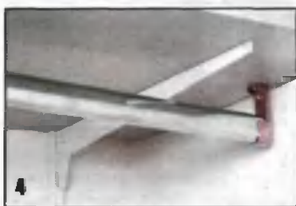
4 Штанги для подвески плечиков — это трубы овального сечения. Их укладывают на опоры, прикрепленные шурупами снизу к полке.
