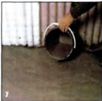
Раствор выливают на пол в количестве, позволяющем равномерно распределить его по поверхности пола. Начать лучше от стены, противоположной двери.
