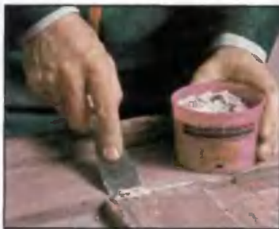
Ремонтная шпатлевка — это крупнозернистый материал для заделки крупных трещин и щелей. Она годится не только для древесины, но и для ремонта штукатурки/камня.
